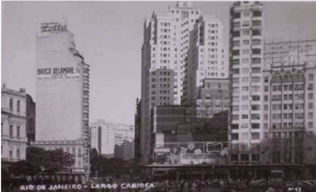
Foto 03 - Vista do edifício Liberdade no ano de 1940 com sua concepção original
